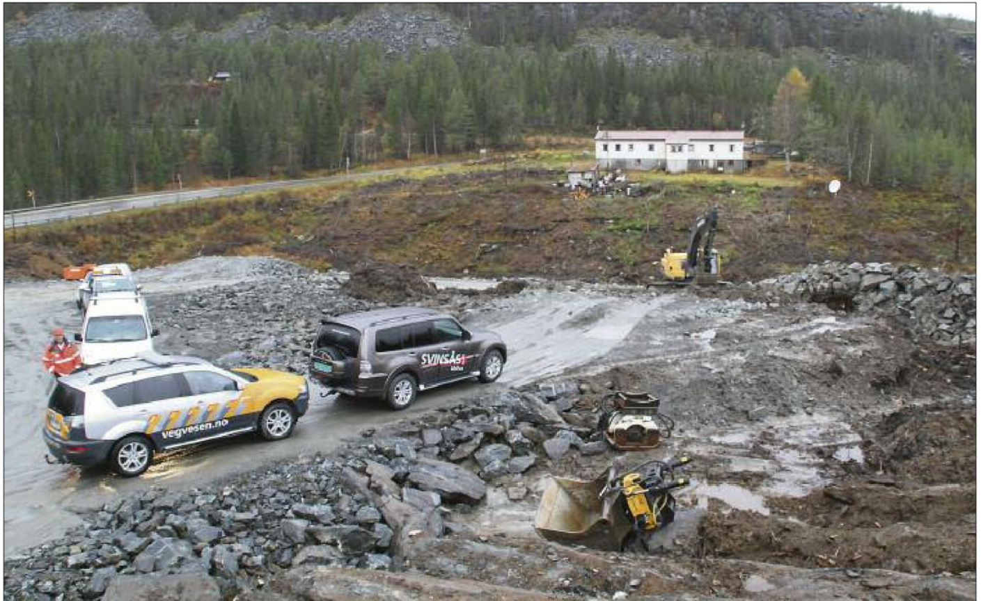
MIDT I VEIEN: overskuddsmasse fra utbyggingen av Krinsvassbrua blir nå deponert i Rødsjøsvingen omtrent der den nye veien er planlagt.
